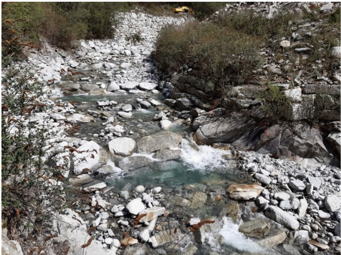
Figura 2: Sopra: esempio di serie di rampe non strutturate realizzate sul fiume Landquart, Canton Grigioni, Svizzera (vista verso monte). Sotto: esempio di rampa struttura "step and pool" sul fiume Maira a Promontogno, Canton Grigioni, Svizzera (vista verso monte). Fonte: Laboratorio 3D .
