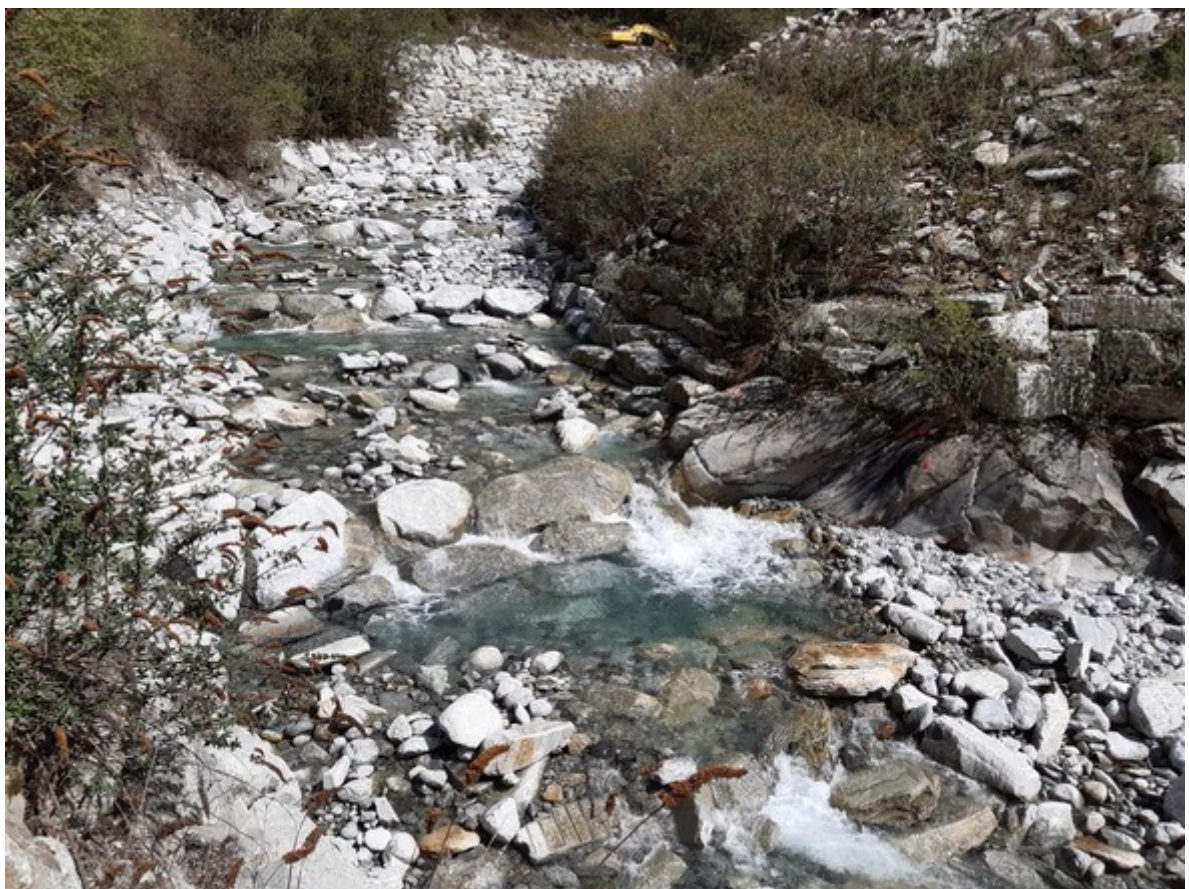
Figura 64 - Sopra: esempio di serie di rampe non strutturate realizzate sul fiume Landquart, Canton Grigioni, Svizzera (vista verso monte). Sotto: esempio di rampa struttura "step and pool" sul fiume Maira a Promontogno, Canton Grigioni, Svizzera (vista verso monte). Fonte: Laboratorium 3D
